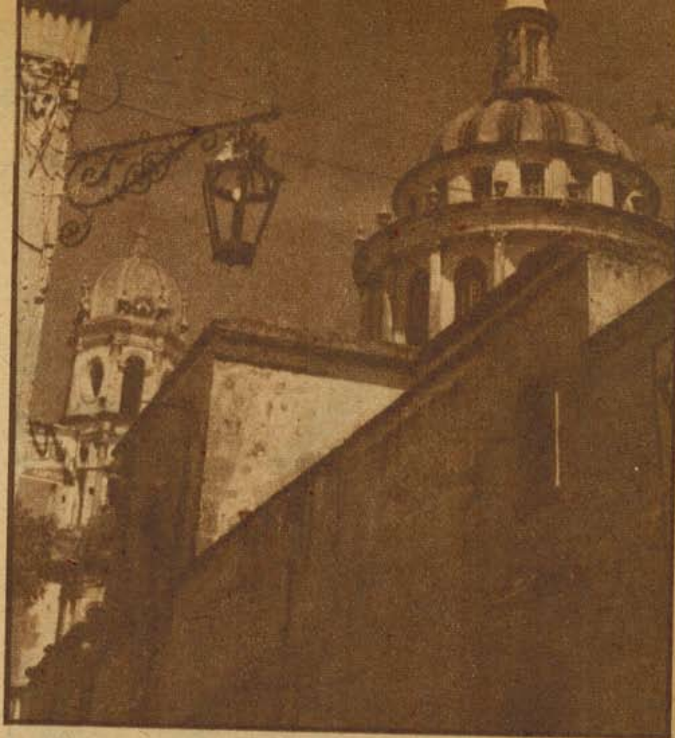
CUPULA del Santuario de la Soledad, de San Pedro Tlaquepaque, cuya bóveda está hecha con cántaros de barro.—ABAJO: Uno de los ladrilleros del barrio de Santa María, dónde se fabrica el hermoso ladrillo de perón o chapeteado, que tanto carácter da a las casas tapatías.
