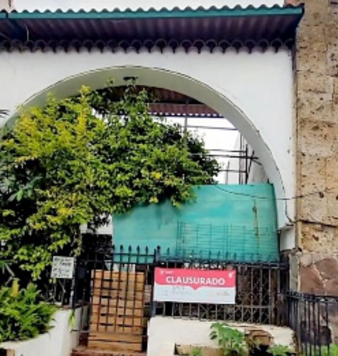
■ En la finca ubicada en Avenida La Paz 1887, que es obra de Luis Barragán, se colocaron sellos de Clausura.
